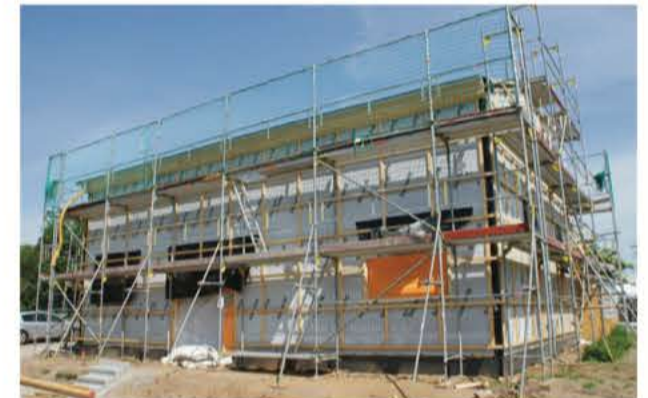
Wo derzeit Baugerüste mit Sicherheitsnetzen stehen, wird bald eine Innovationstagesstätte eröffnet.
